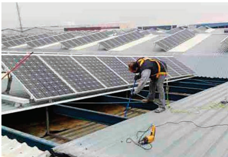
Ilustración 37: Trabajos de impermeabilización en cubierta FV. Fuente: MACONI
