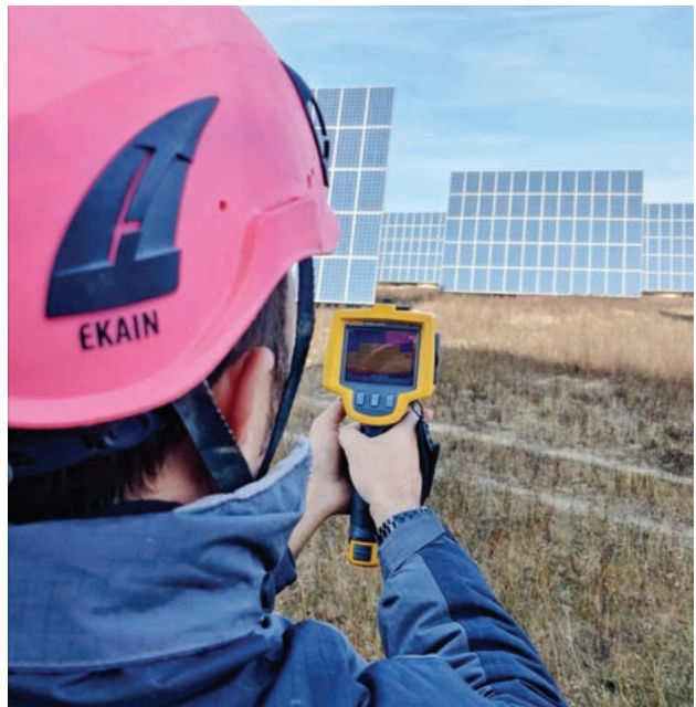
Imagen 5: Equipo técnico de MAGMA realizando un estudio termográfico.
