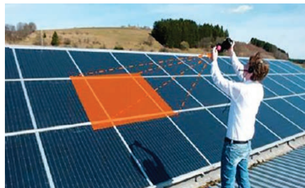
Ilustración 5: Inspección termográfica manual.
