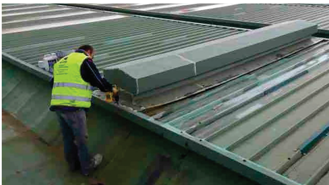
Ilustración 38: Inspección de cubiertas. Fuente: MACONI
