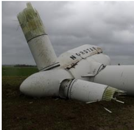
Figura 16: aerogenerador siniestrado en el suelo.
