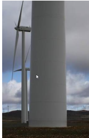
Figura 10: Torre inclinada.
