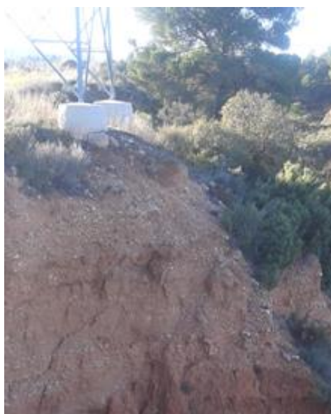
Apoyo LAT en riesgo de colapso por fenómenos erosivos
