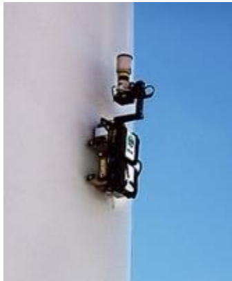
Figura 7: Inspección con robot
