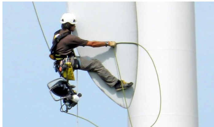
Figura 6: Inspección con cuerdas
