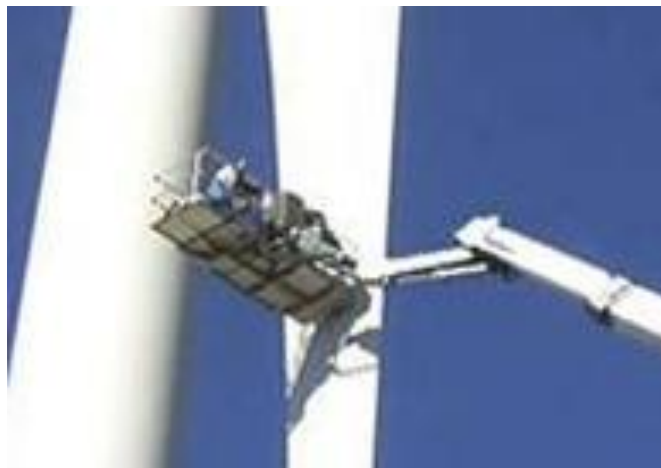
Figura 9: Inspección con cesta
